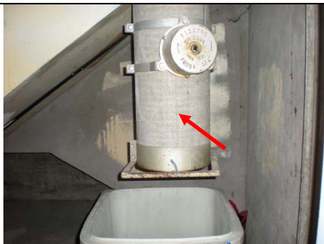
Photo 6 : Conduit Vide Ordure de type amiante ciment
