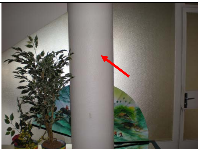
Photo 5 : Conduit Vide Ordure de type amiante ciment
