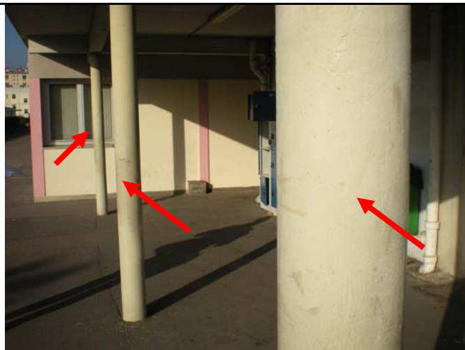
Photo 4 : Poteaux de type amiante ciment
