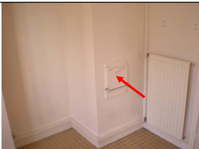
Photo 7 : Conduit Vide Ordure de type amiante ciment
