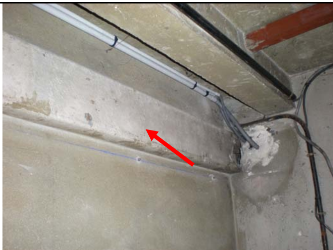
Photo 3 : Conduit de type amiante ciment
