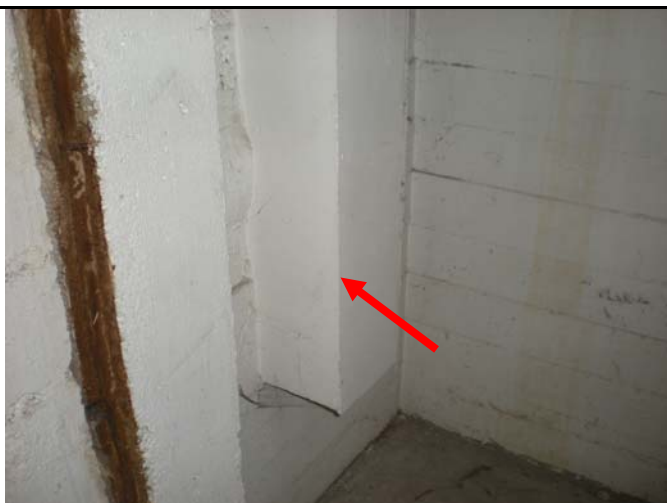
Photo 9 : Conduit de ventilation de type amiante ciment derrière carreau de plâtre (vue de face)
