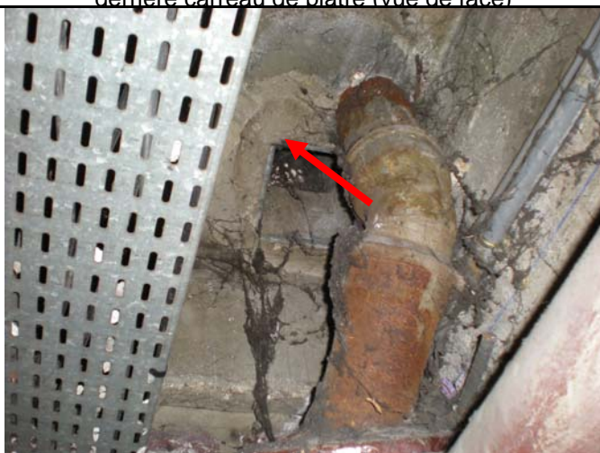
Photo 11 : Conduit de ventilation de type amiante ciment
