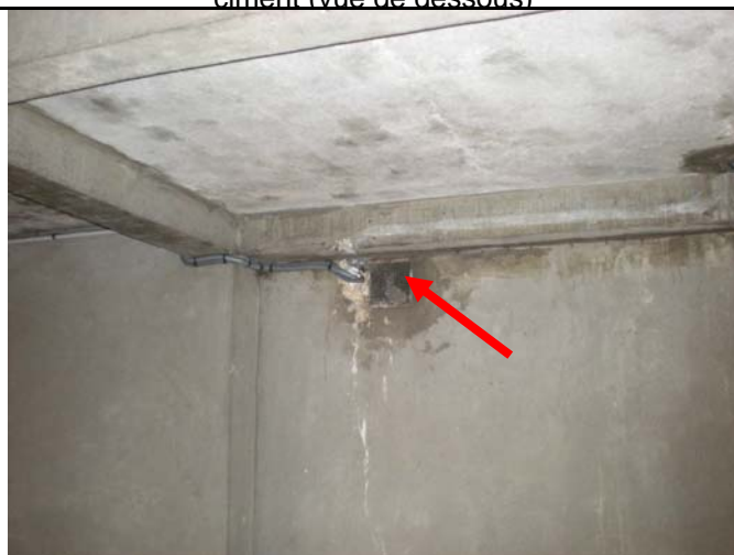
Photo 12 : Conduit de ventilation de type amiante ciment
