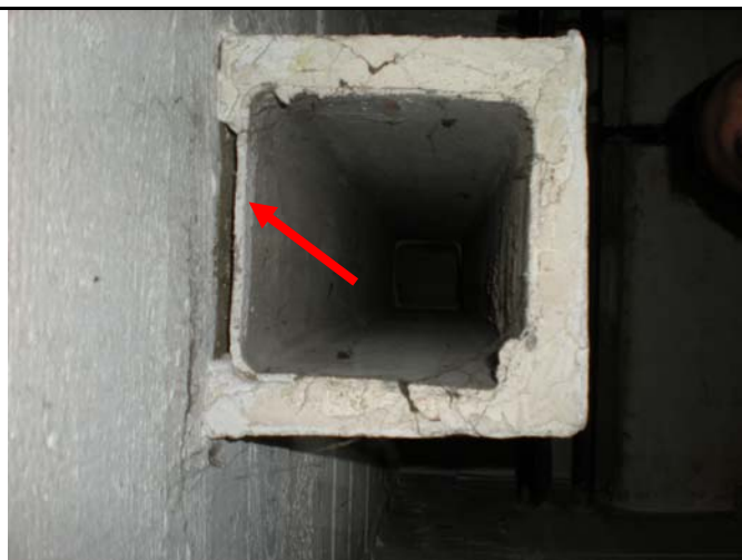
Photo 10 : Conduit de ventilation de type amiante ciment (vue de dessous)
